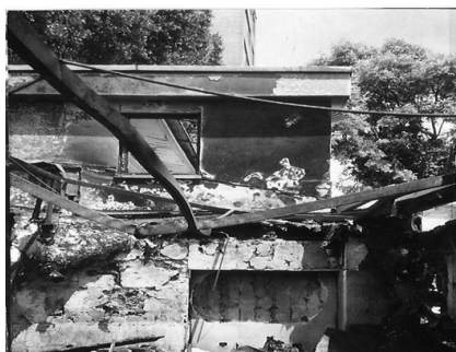
Foto 9: Esta foto es una parte de la casa de la 86, que el grupo Varasanta tuvo que remodelar.
