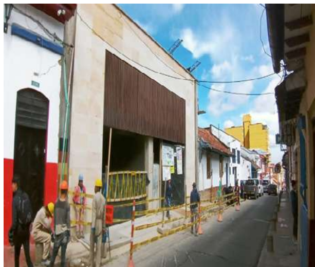
Ilustración 2 Obra de ampliación del ICANH
