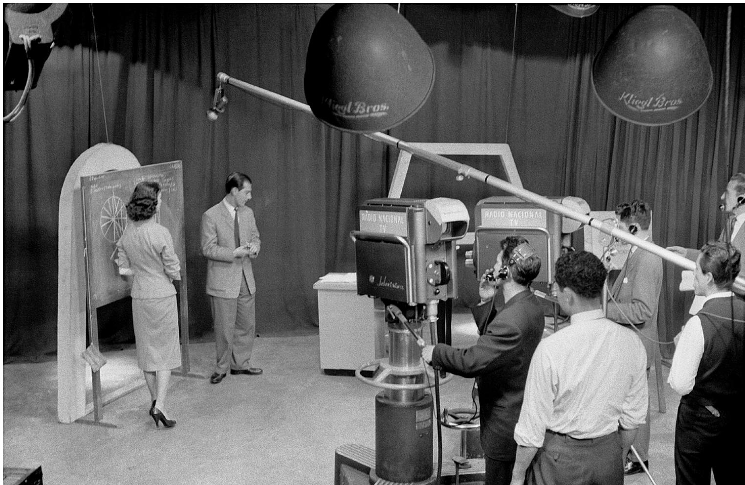
**Sesión de teleclase de geometría.** Al micrófono pegado al poste largo que se eleva sobre la cabeza de los actores se le llama *boom* y es clave para asegurar la buena calidad del audio durante la transmisión. Es un micrófono omnidireccional, es decir que capta el sonido en todos los ángulos. 1962 - Archivo ACOTV.
