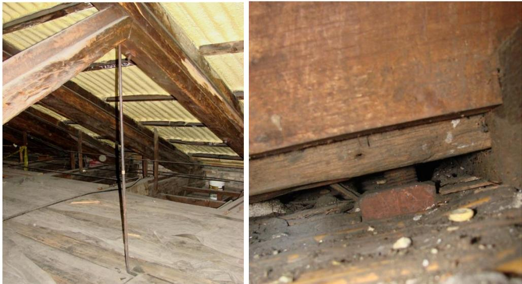
*Detalle de la estructura y el tensor.*
