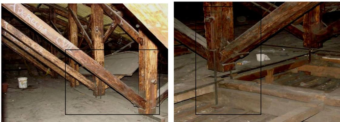
*Pendolones y tensores de los cuales pende el canasto de caña de castilla y el mortero con la pintura mural.*
