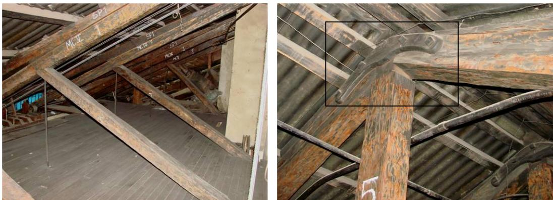
*Sistema de vigas y refuerzo en hierro en el área de unión*
