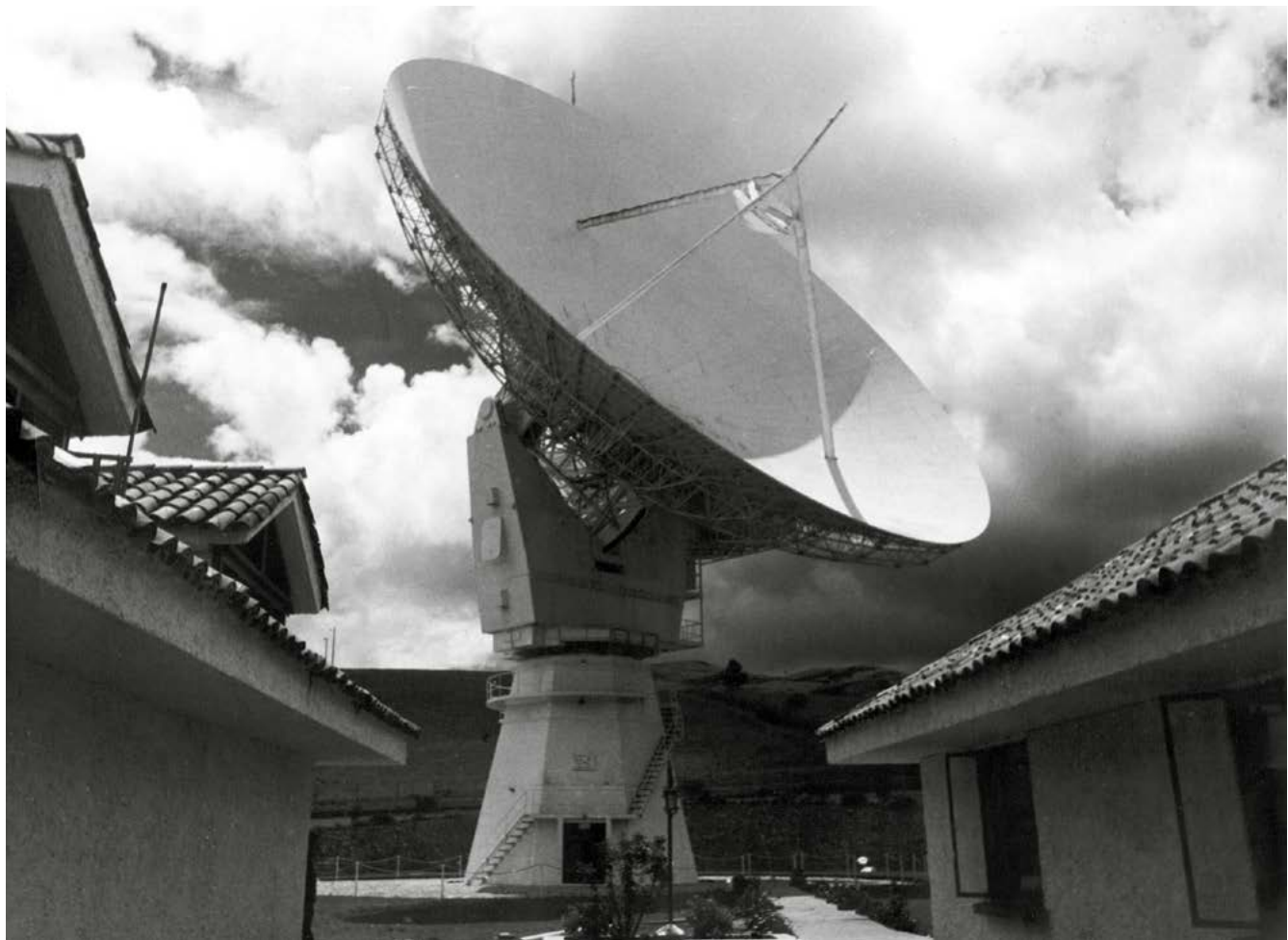
Chocontá, pionera en señal satelital. Una de las antenas de la estación terrena satelital ubicada a las afueras del municipio de Chocontá (Cundinamarca). Inaugurada en 1970 como propiedad de Telecom, marcó un hito en las telecomunicaciones, permitiendo transmitir eventos internacionales. 1970 - Archivo ACOTV.
