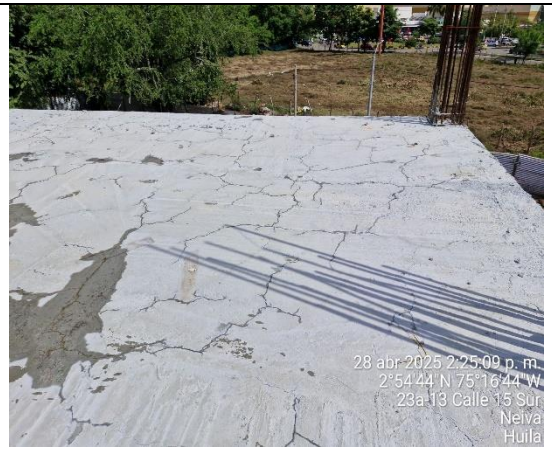
Foto No.4 - Grietas en la placa maciza entre el segundo y tercer piso del bloque de aulas medias 1 I.E. Cacique Pigoanza ejecutada mediante el contrato 030 de 2023.
