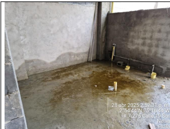
Foto No.3 - Panorámica de una de las baterías sanitarias donde no se han ejecutado enchapes, ni aparatos sanitarios ni divisiones pagadas mediante el contrato 030 de 2023
