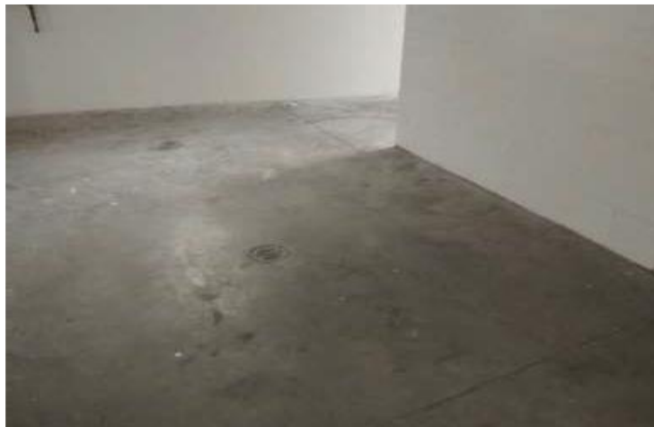
“Fotografía 2. Punto de Desagüe Zona Cocina de Restaurante, 3er piso”
