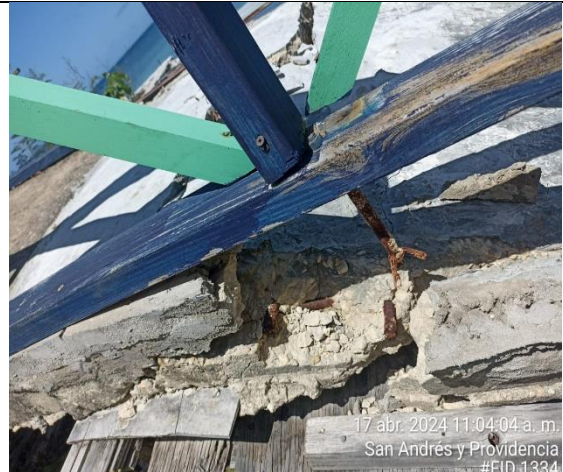
Fotografía 3. Unión rampa de acceso y baranda
