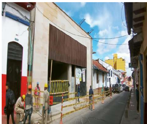
Ilustración 2 Obra de ampliación del ICANH
