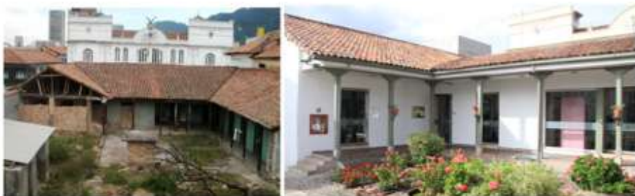
📷 Casa Rivas Sacconi antes y después de la restauración fase I.
